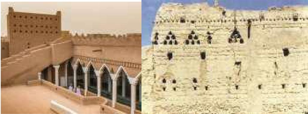
شكل (8) يوضح دور الفتحات الصغيرة في حركة الهواء
